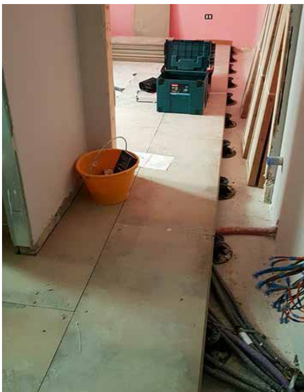
Disposizione giunti sotto battente porta
